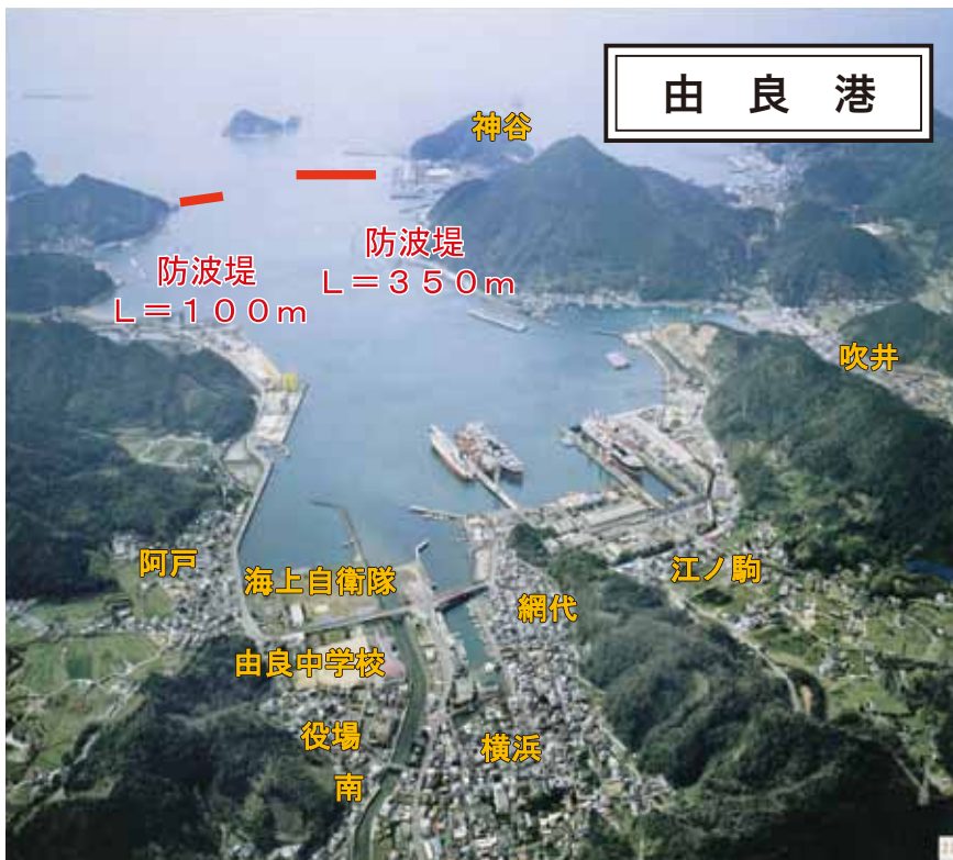
令和5年度完成予定の「由良港湾防潮堤整備事業」
