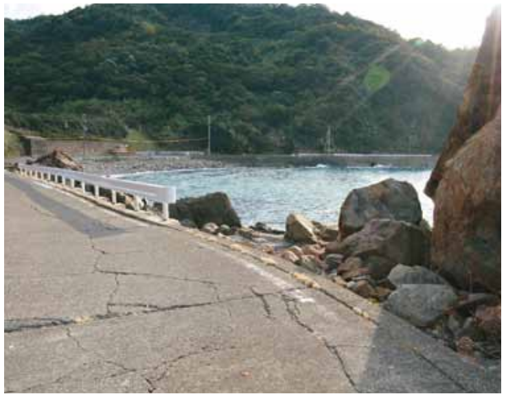
埋立て工事予定箇所(小引|地内)
