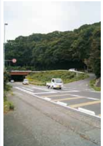
国道から県道の接続箇所(阿戸地内)
