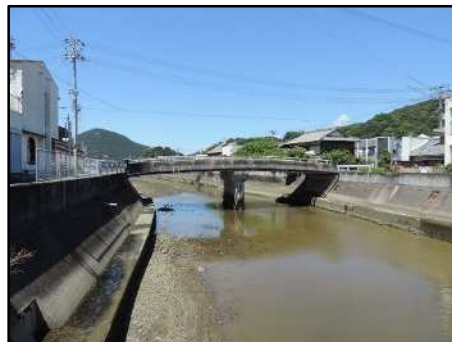
【由良橋（コンクリート橋・里）】
