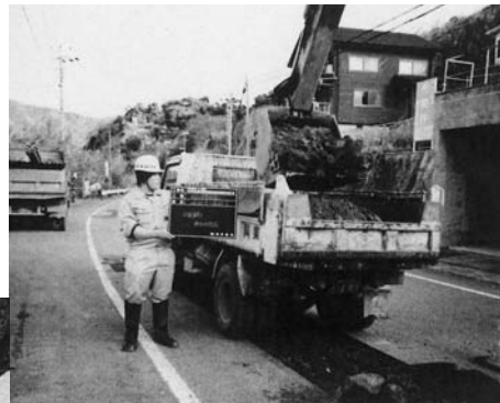
神谷・大引 漁集工事現場
