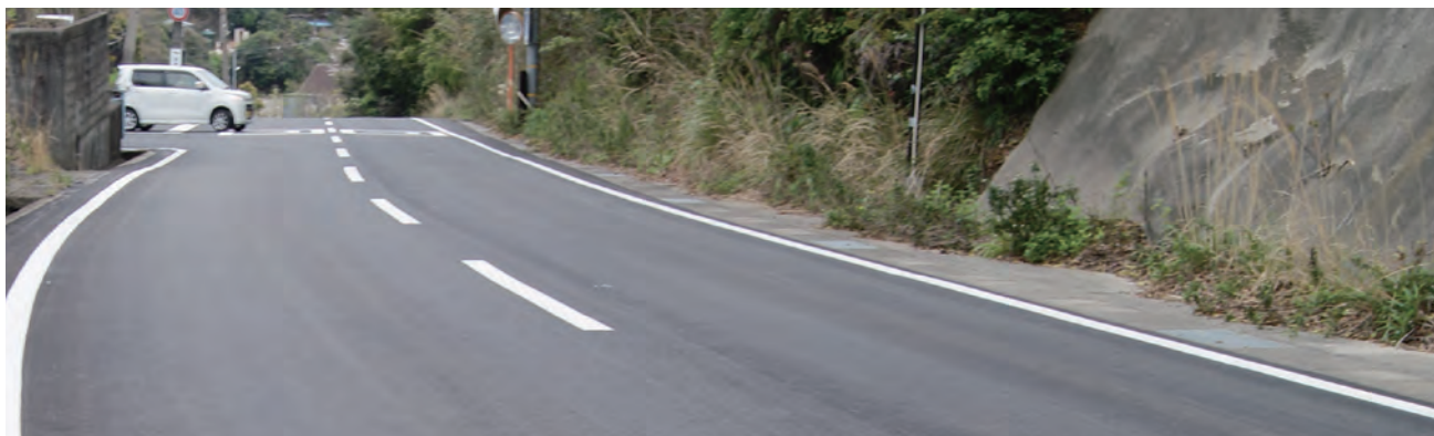
町道維持工事（斎場付近）
