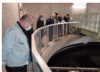
沈澱池（由良クリーンセンター）
