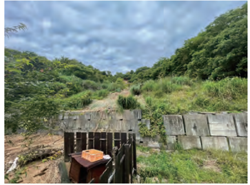
県営工事予定地（由良町里地内）
