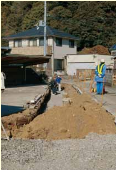
避難道の整備 (横浜地内)
