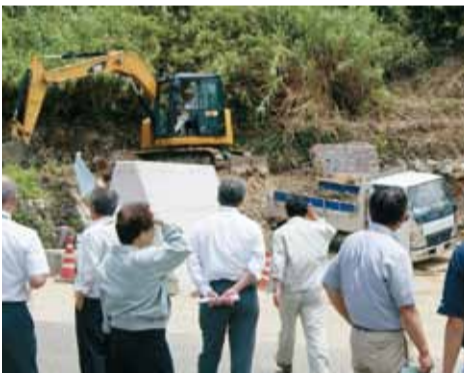
大引地区道路改良工事
