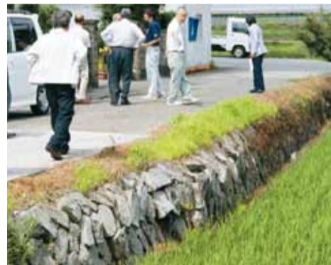
門前地区道路改良工事
