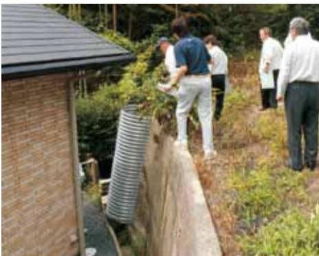
江ノ駒地区水路補修工事
