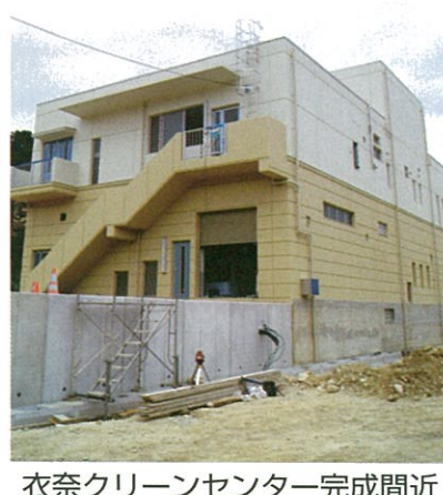
衣奈クリーンセンター完成間近
